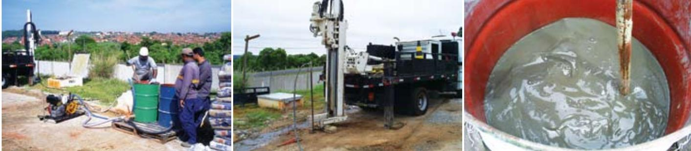
Atividades desenvolvidas em campo, como preparação da mistura de EHC-M e injeção, com o emprego de equipamento tipo Geoprobe
